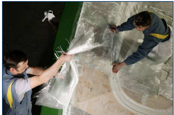
Technologie de fabrication en moule fermé © G. Plisson
